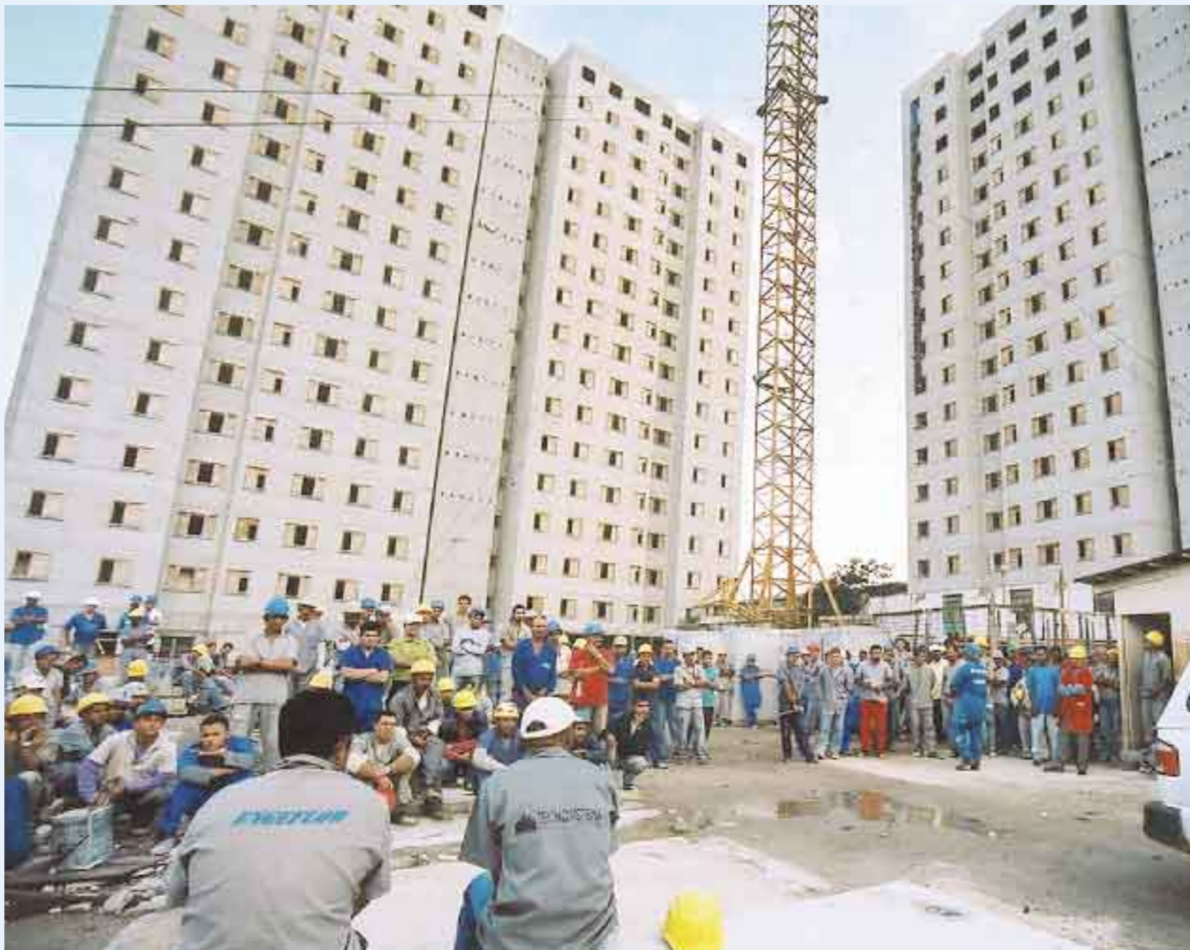
Operários param o trabalho para reivindicar melhores condições de segurança nas obras, aumento de salário e redução da jornada
